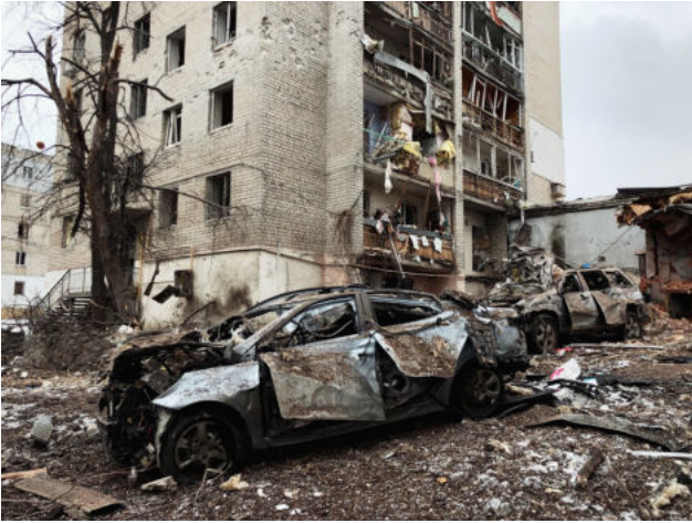
Durch russische Luftangriffe zerstörte Häuser und Wohnungen in Charkiw in der Ostukraine (Foto vom 08.03.2022)
